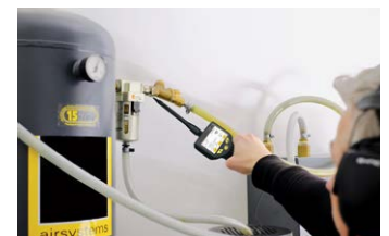
Leckagesuche mit Richtrohr
